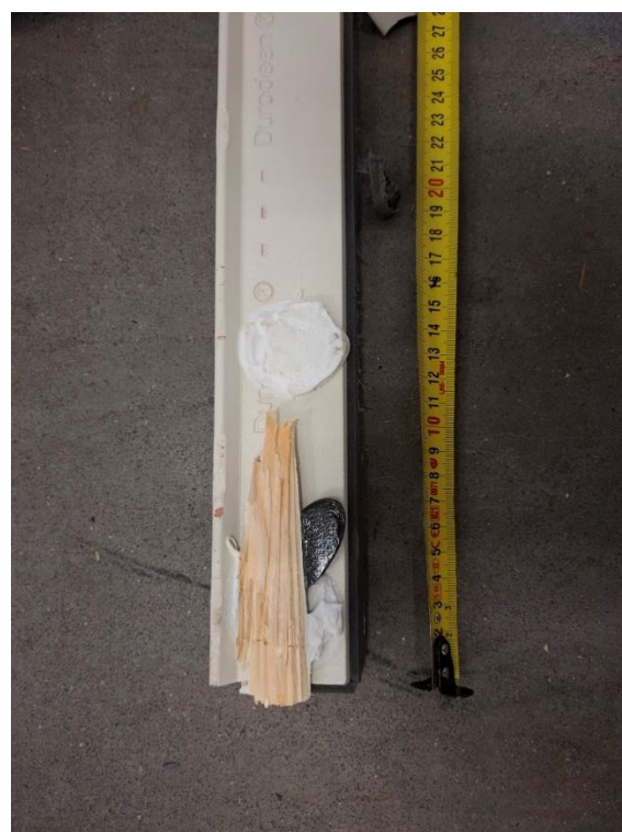
Foto 4: lijmdot en pad op neuslat
