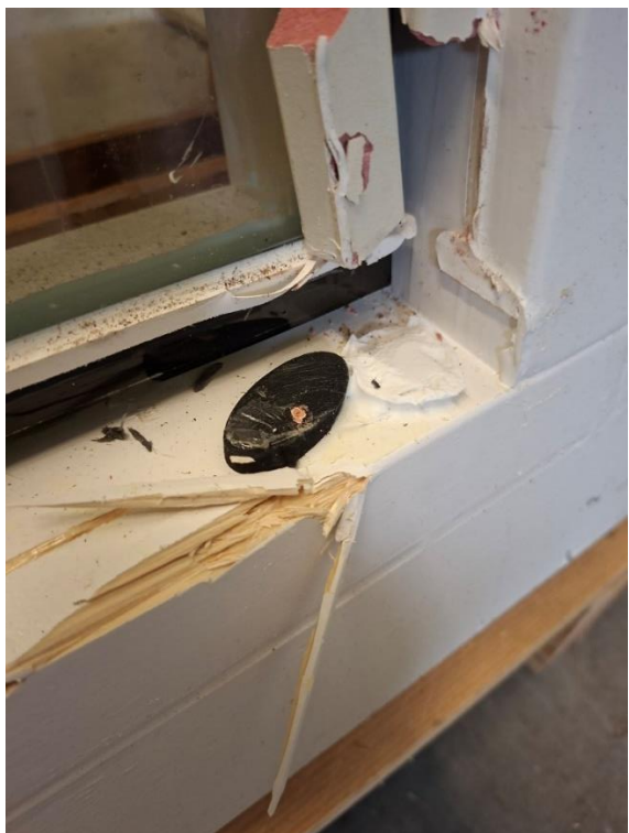
Foto 3: neuslat verwijderd, lijmdotten en lijmpads
