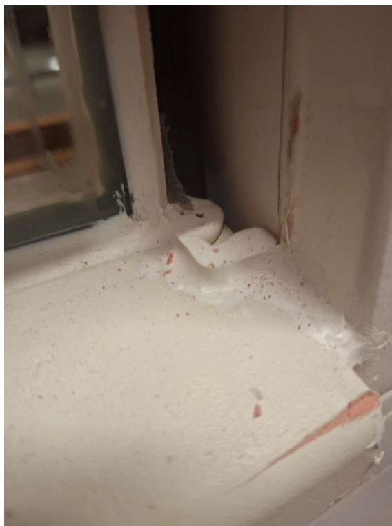
Foto 2: staande glaslat verwijderd
