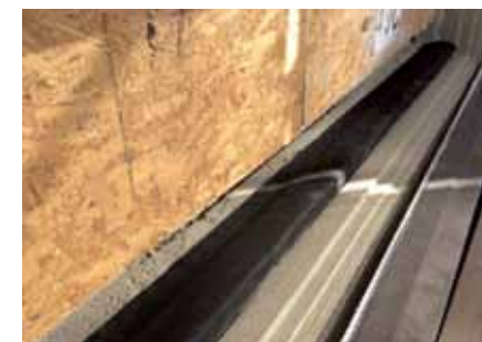
Het nieuwe Durodeen stelkozijn met de Triflex band
