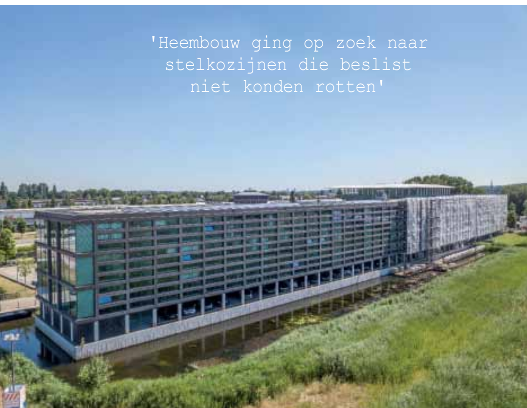
Het project in volle gang. De steigers staan op pontons.
