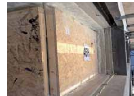
Ook een hoekopstelling is met Durodeen geen enkel probleem, aangezien het materiaal zich laat verwerken als hout
